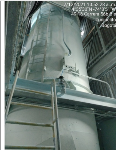
Fotografía 7. Sistema de transporte air lift
