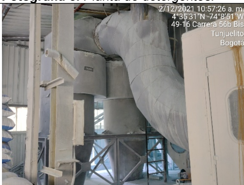
Fotografía 5. Ciclones torre de secado
